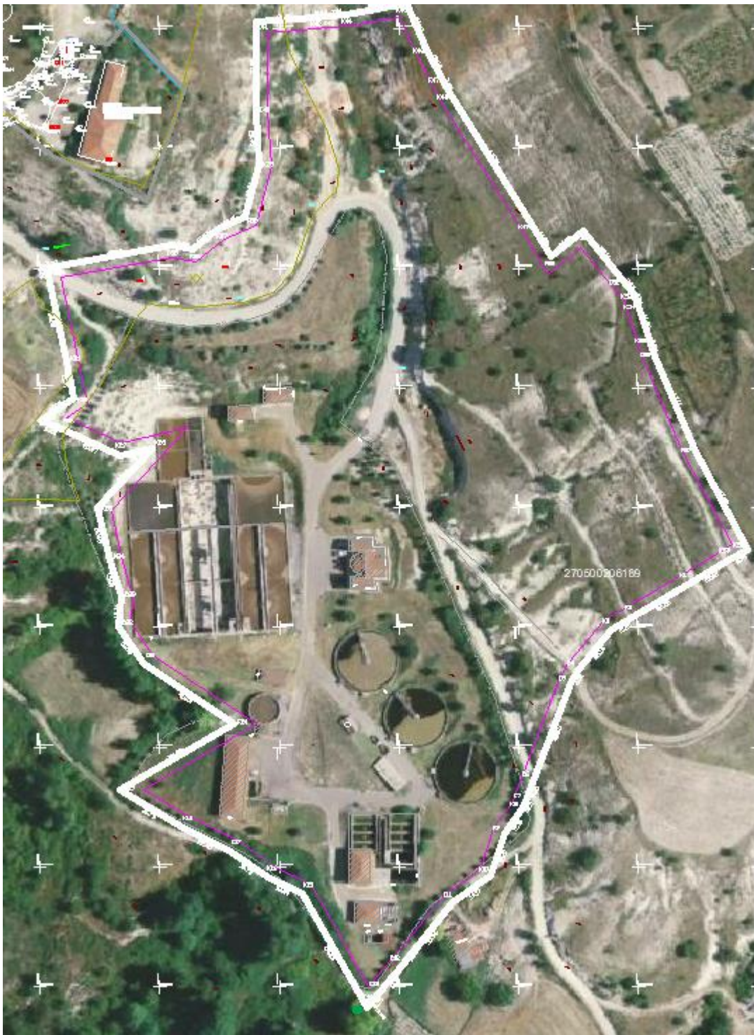
Εικόνα 0.1 Χώρος εγκατάστασης φωτοβολταϊκού σταθμού
